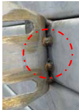
Soudures oxydées
